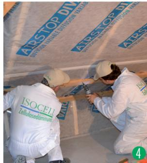
Nun werden die Latten im Achsabstand von ca. 30 cm angebracht. Im Idealfall wird die Lattung direkt auf der Stoßverklebung positioniert, um die Klebestellen zusätzlich zu entlasten.
