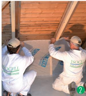
Die Dampfbremse wird überlappend verlegt und mittels Tackerklammern mechanisch befestigt.
