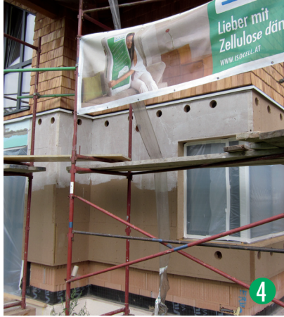
Kurz bevor die ISOCELL Zellulosedämmung eingebracht wird, werden in die Hohlräume Löcher für den Einblasschlauch gebohrt.
