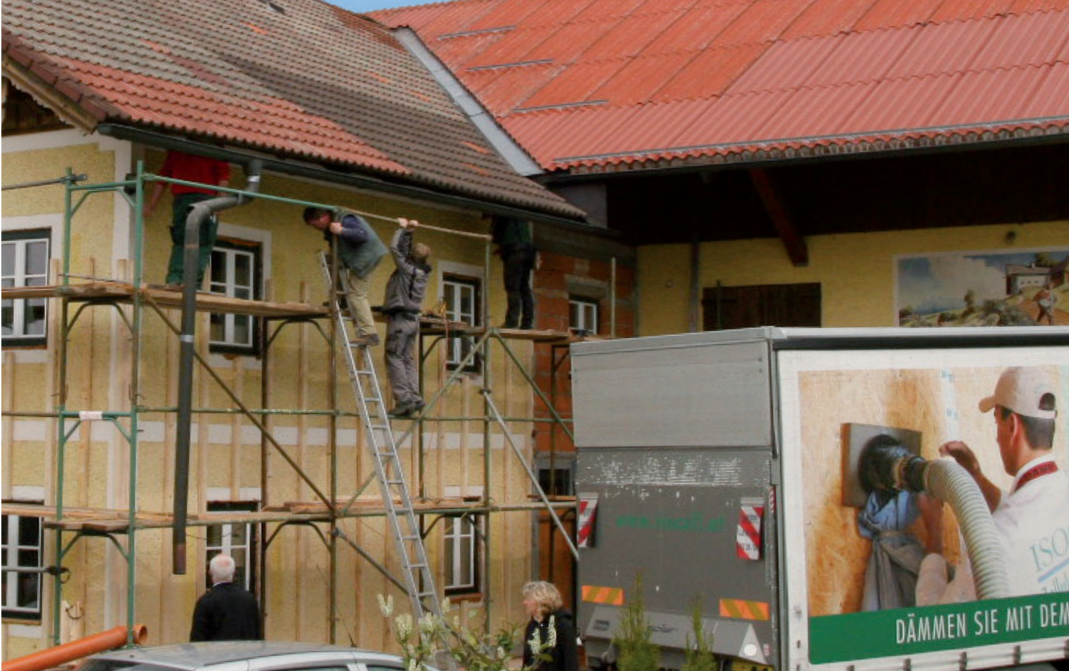
Kurz bevor die ISOCELL Zellulosedämmung eingebracht wird, werden in die Hohlräume Löcher für den Einblasschlauch gebohrt.
