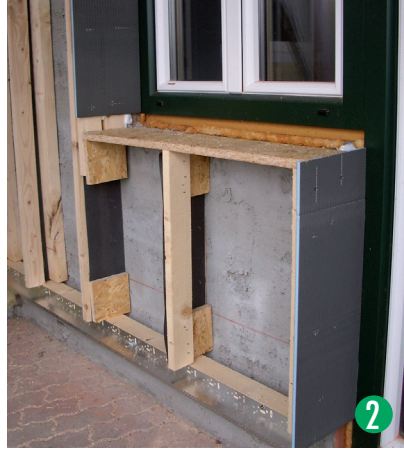
Fenster- und Türleibungen müssen rundum abgeschlossen werden. Hohlräume unter 10 cm werden per Hand mit Zellulose ausgestopft.
