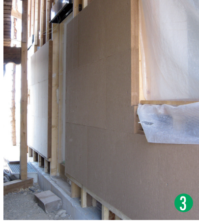
Auf die lotrecht ausgerichteten Abstandhalter wird das jeweilige Putzträgermaterial montiert. Bei hinterlüfteten Fassaden wird eine diffusionsoffene Holzwerkstoffplatte angebracht.
